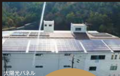
太陽光パネル
